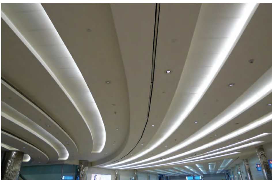
Nedhængt loft med SLAT™ (Self Levelling Access Trim) det unikke patenterede Coopers system
